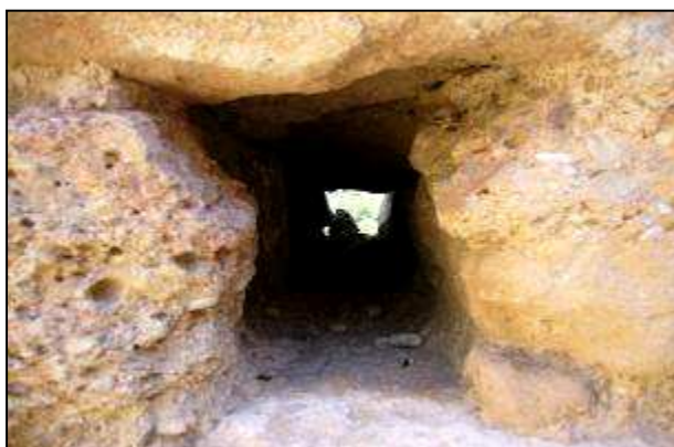
Una de les espitlleres per a la defensa de la torre
