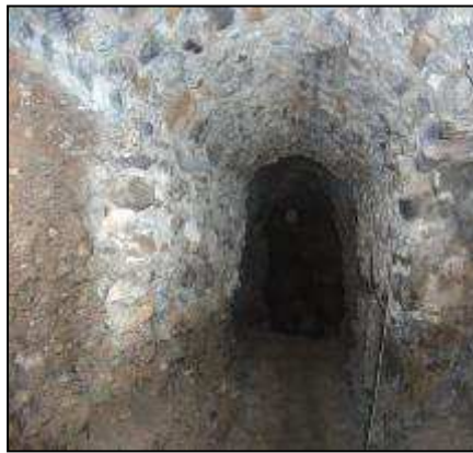
Interior de la mina de Cal Valls (masia enderrocada l'any 2006)
